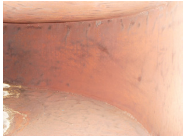
Фото до после эксплуатации дымовой трубы:
