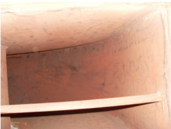
Фото до эксплуатации дымовой трубы:
